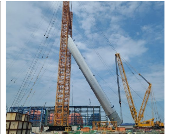
세방 크라모 중량물 설치 작업
